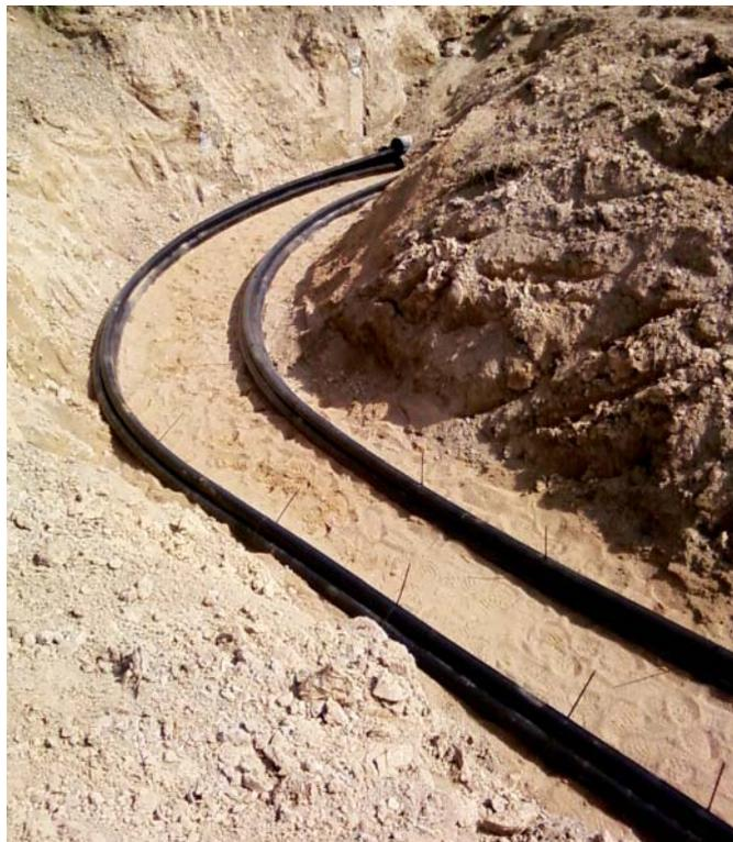
**Рис. 5. Укладка кабелей в траншее (стяжка медной проволокой)**
