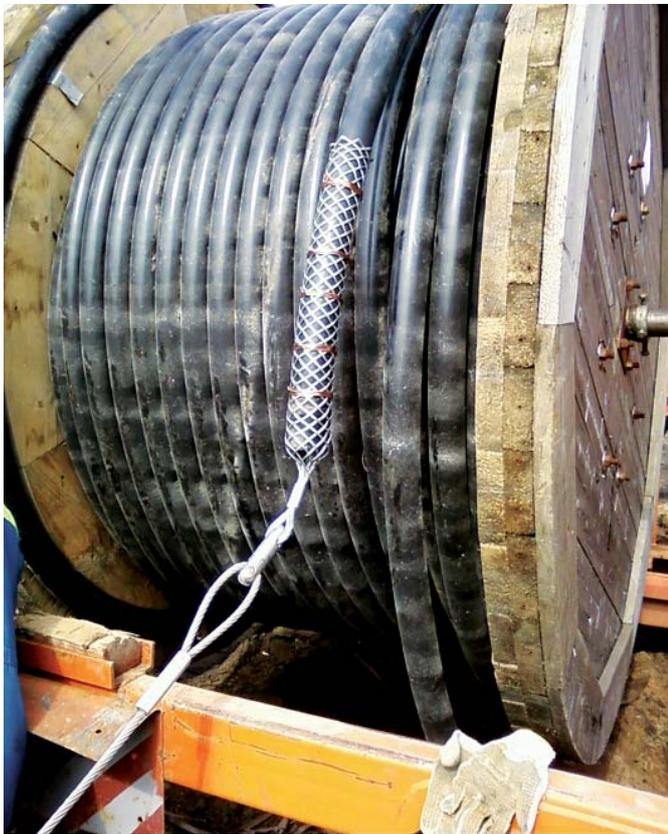
**Рис. 2. Повреждение оболочки кабеля при протяжке через трубу без воронки**
