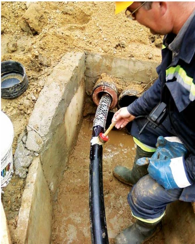
**Рис. 7. Герметизация труб с кабелем монтажной пеной**
