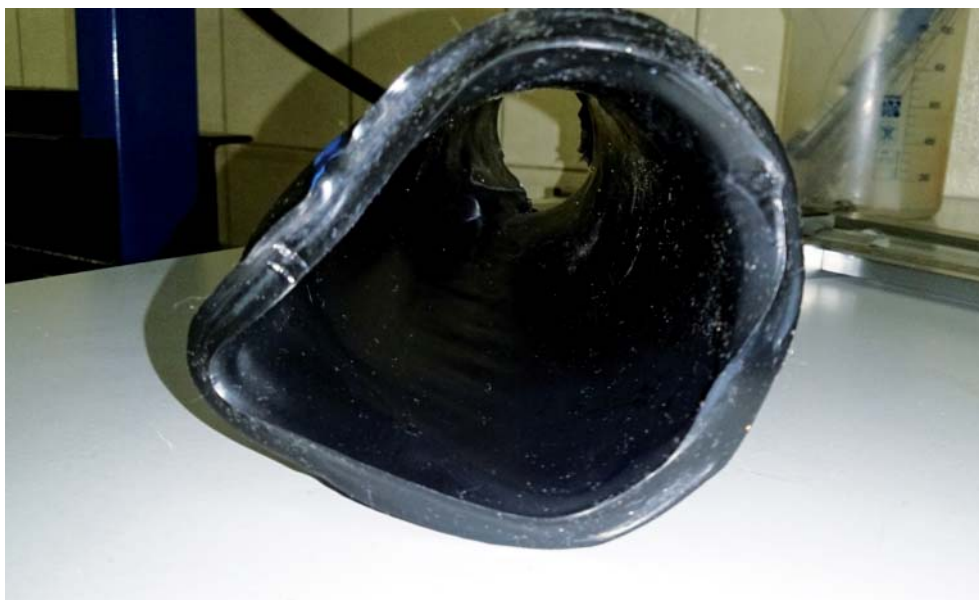
Рис. 5. Перегрев ПНД-трубы и её деформация
