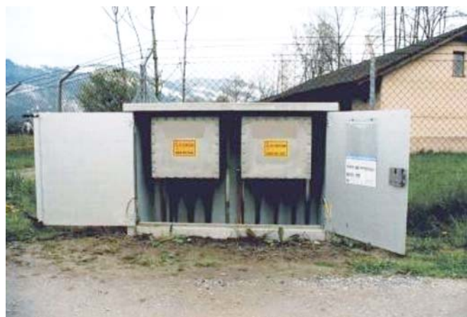
Рис. 1. Размещение коробок транспозиции в наземных сооружениях
