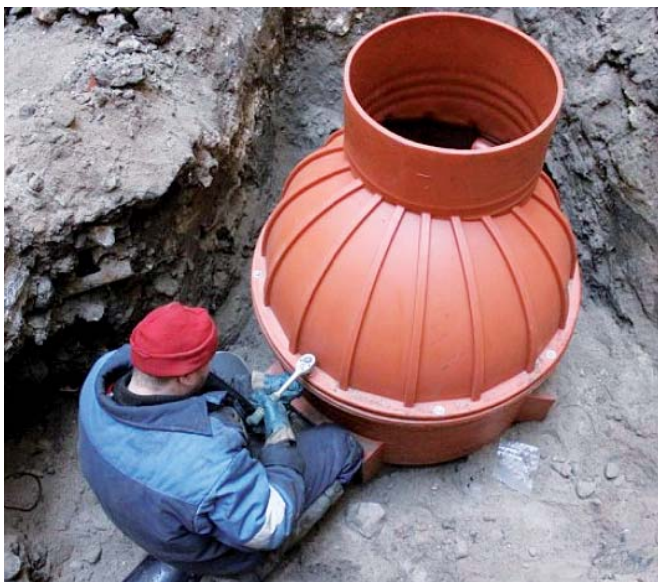
Рис. 4. Полностью пластиковый колодец 100% герметичности
